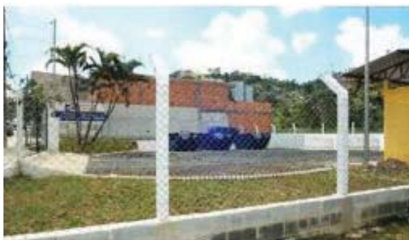
Guarulhos/SP: Área de deposição irregular de resíduos (acima), transformada em Ecoponto (abaixo).
