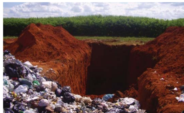
Aterro Sanitário de Pequeno Porte (Rafard/SP)
